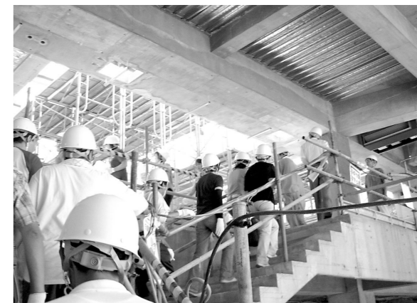
・校舎工事の現場見学(2004年7月) 先生方も参加した現場見学。躯体は完成しており、新校舎の使い方を想像しながらの見学でした。
